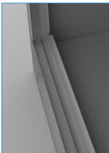
Instalacja odpływowa do zbierania wody
