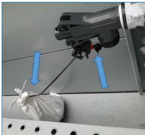
Bevestiging en inwikkeling van de vlotterbal
