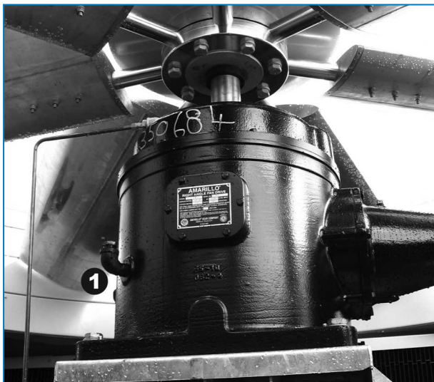
Tandwielaandrijving met enkelvoudige overbrenging
