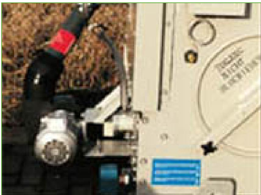
Reubique la bomba de recirculación de agua **en el extremo de conexión** de los ventiladores revestidos con atenuadores de sonido y mejore el acceso para inspección y mantenimiento.
