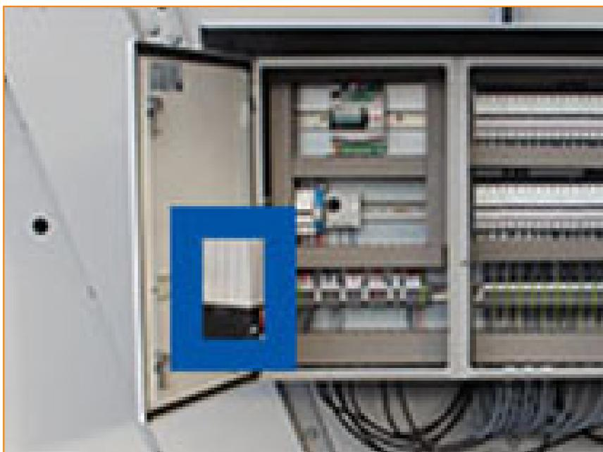
Le coffret électrique de série est prévu pour des températures ambiantes de  $-10^{\circ}\text{C}$  maximum. Pour les climats encore plus froids (températures ambiantes jusqu'à  $-40^{\circ}\text{C}$ ), une résistance antigel permet de prévenir les dommages des composants internes du coffret électrique.
