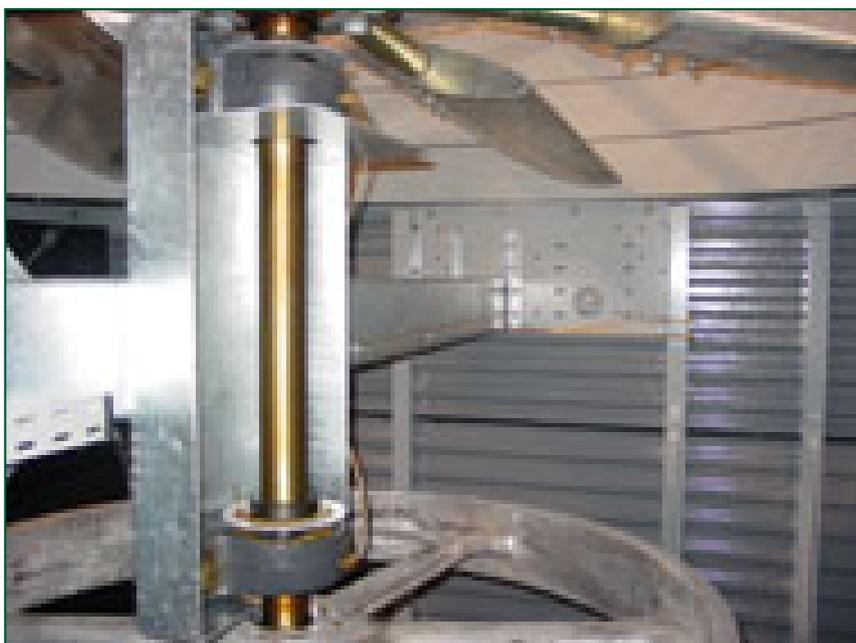
Le linee di lubrificazione estese con ingrassatori facilmente accessibili, si possono utilizzare per lubrificare i cuscinetti dell'albero del ventilatore. Gli ingrassatori sono ubicati nell'area del plenum, vicino al portello d'ispezione.
