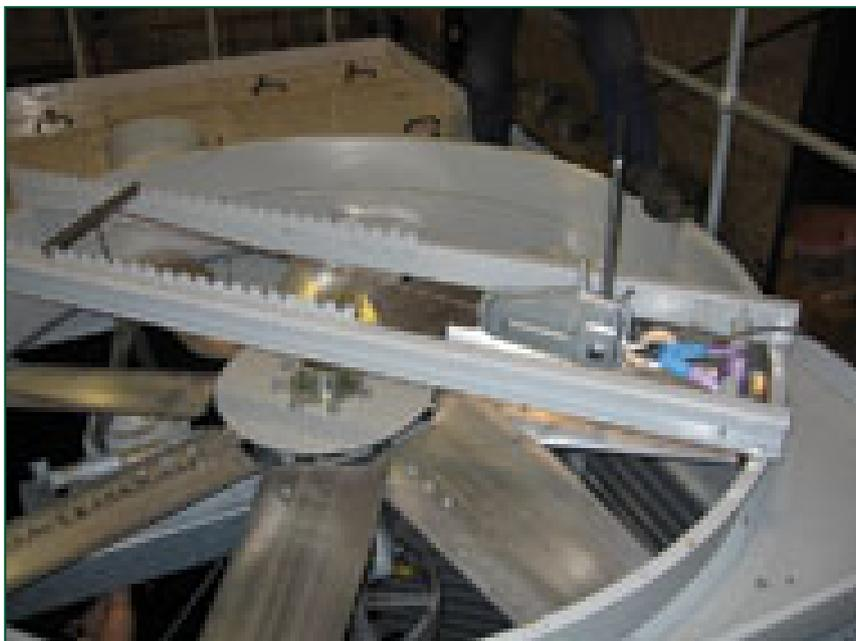
Questo sistema di rimozione delle parti meccaniche leggere installato **facilita la rimozione o l'installazione dei motori dei ventilatori o dei motoriduttori.**
