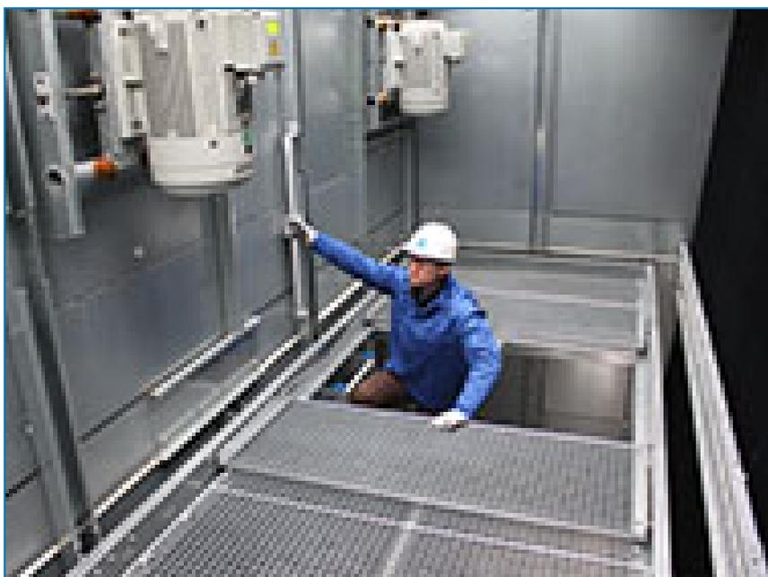
Oltre a permettere **un agevole accesso alle sommità interne delle unità**, la piattaforma interna installata permette di effettuare inoltre interventi di ispezione e manutenzione in modo **più agevole e sicuro**, in conformità con le **direttive sulla sicurezza dell'Unione Europea**.
