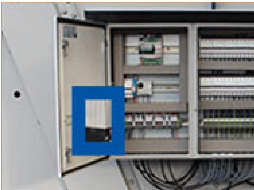
Электропанель по умолчанию предназначена для установки в условиях при температуре окружающей среды не ниже  $-10^{\circ}\text{C}$ .
