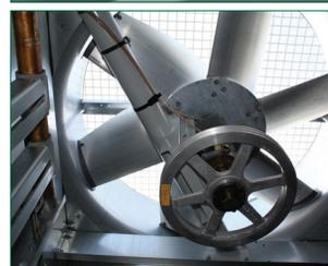
Sistema de transmisión de ventilador de fácil acceso con líneas de lubricación prolongadas\* Puerta de acceso grande y pasarela interna\*
