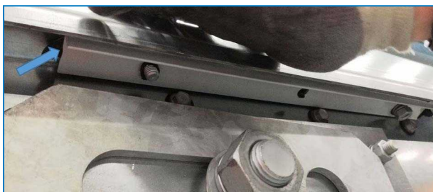
Установленный уплотнительный профиль
