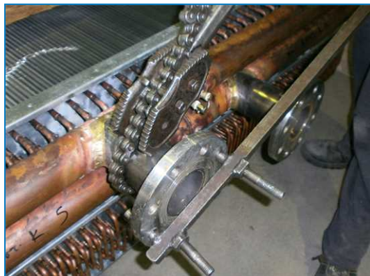
Установка фланцев с резьбовым соединением
