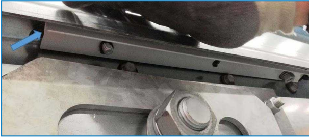
Perfil de sellado instalado
