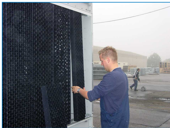
Démontage des déflecteurs d'entrée d'air
