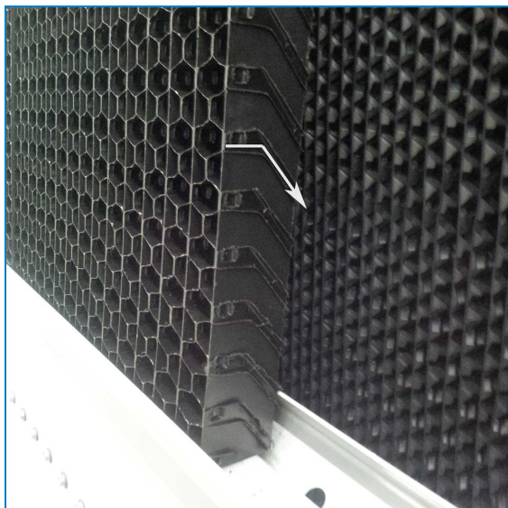
Orientation des déflecteurs d'entrée d'air à 3 fonctions
