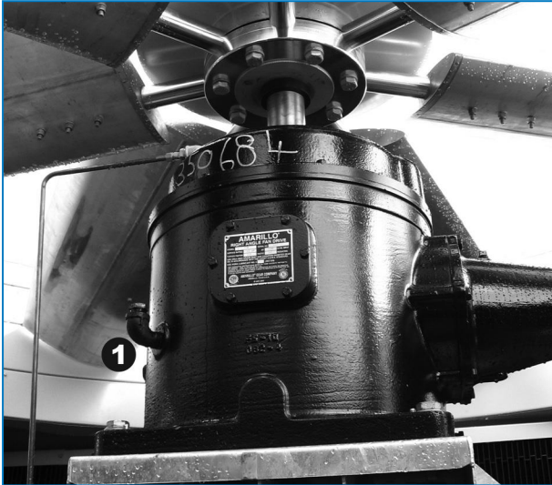
Transmisión por caja reductora con reducción simple
