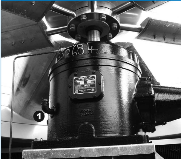
Transmisión por caja reductora con reducción simple
