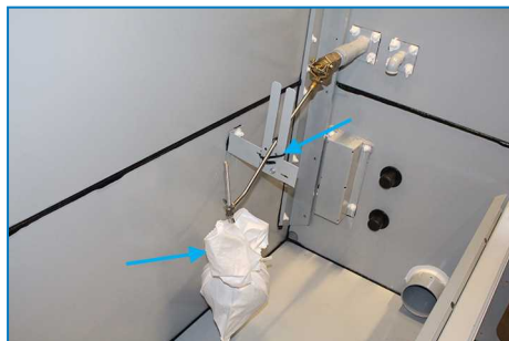
Fijación y envoltura del flotador de bola
