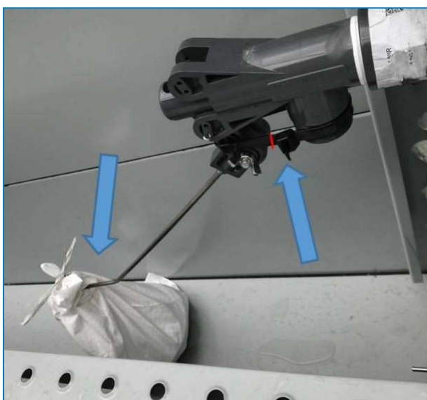
Fissaggio e avvolgimento della palla galleggiante
