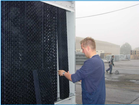
Rimuovere gli schermi d'ingresso combinati
