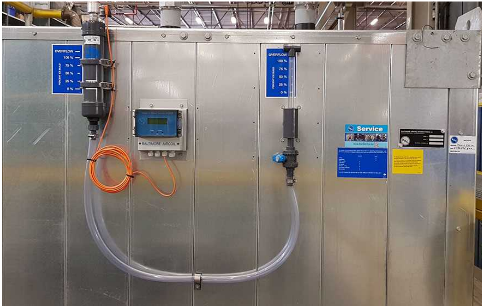
Ice-Logic™ con sensore radar
