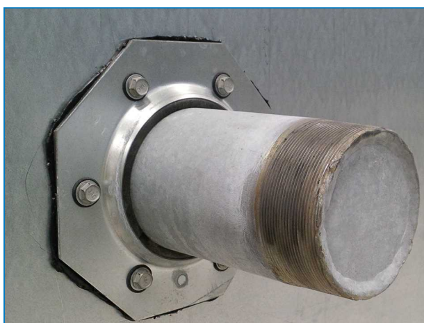
Attacco batteria chiusura inferiore (sulle torri di raffreddamento a circuito chiuso con attacchi fino a DN 100).
