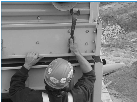
Allineamento dell'angolo con spina di assemblaggio
