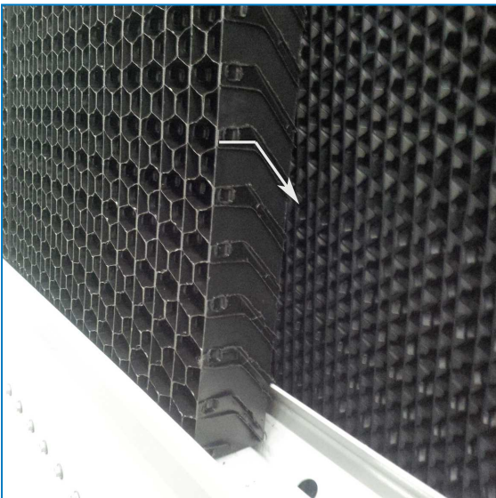
Ausrichtung des Lufteintrittsschutzelements
