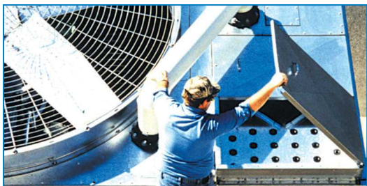
Heißwasserbecken und optionale Abdeckungen Wasserverteilwanne
