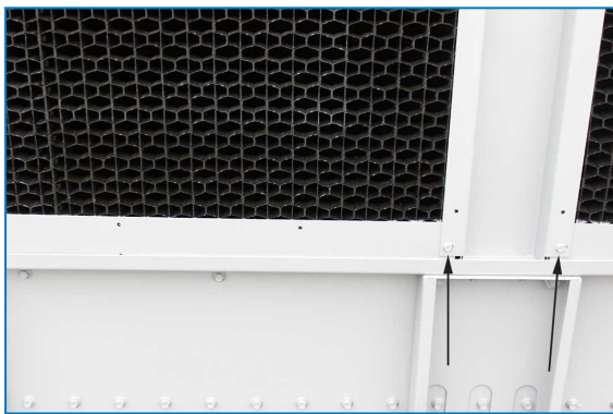
Transportbänder entfernen
